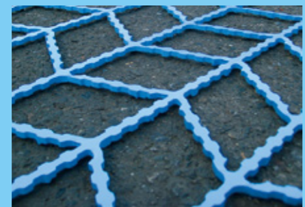
エポキシ樹脂塗装による防食
