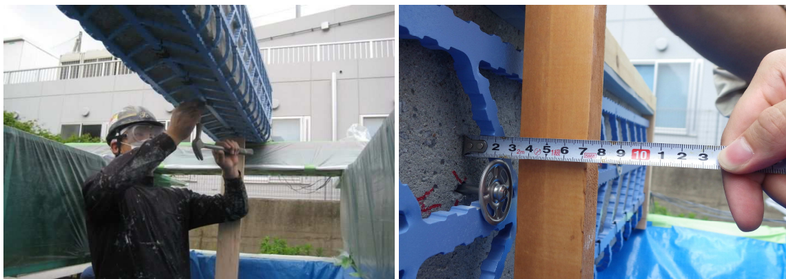
写真 4.3 グリッドメタルの取り付け状況
