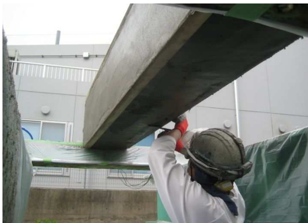
写真 4.5 充填材の仕上げ状況
