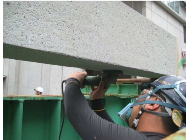
(b) 下地処理状況（ディスクサンダー）
