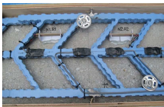
写真 4.4 グリッドメタルの重ね継ぎ手 (3 格子重ね合わせた場合)
