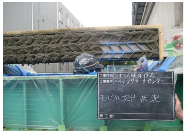
写真 4.4 充填材吹付け状況
