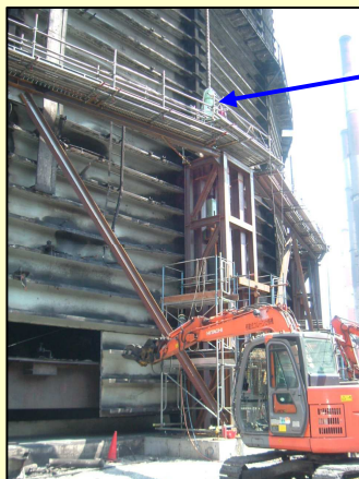
地上で一般の重機を用いて壁板・支柱を切断撤去する。
