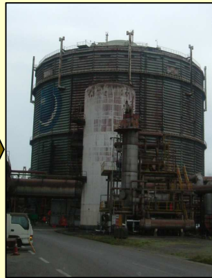
解体が進むにつれて次第に低くなっていくガスホルダー
