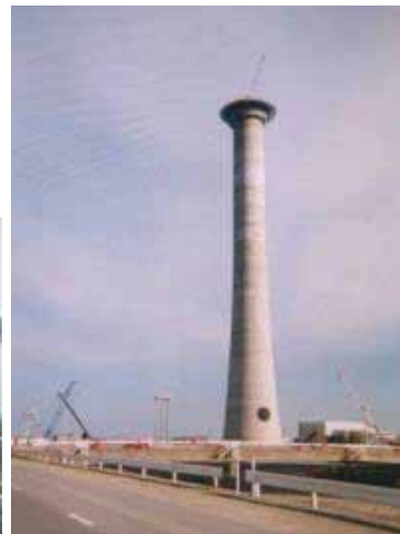
頂部コンクリート工事中
