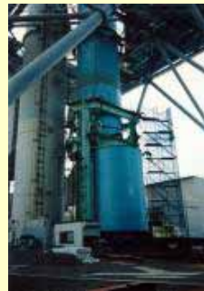
(2) 下部部材挿入・接合
