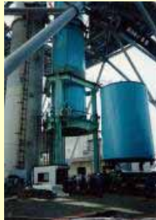
(1) ジャッキで吊上げ、下部部材準備
