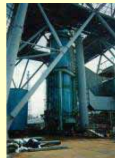
(3) 吊治具を下方へ盛替え
