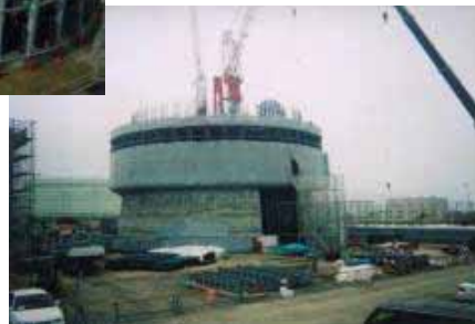
コンクリート打設スタート
