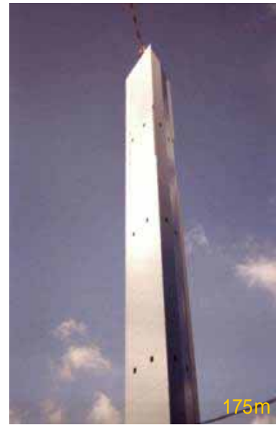
東京都中央区清掃工場 (三角形)
