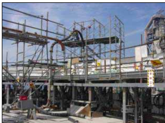
壁コンクリート打設状況
