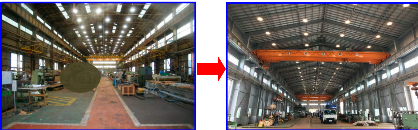
【既存の鉄骨は再利用し、新築建屋と同等レベルの美観や鉄部の防食塗装による延命を実現】
