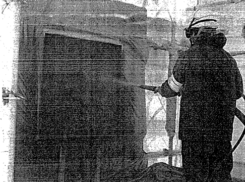
吹付けるだけで施工可能
