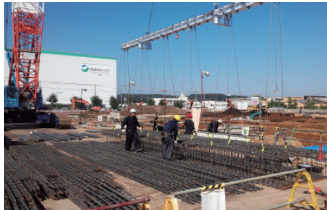
鉄筋ジャバラユニット工法
