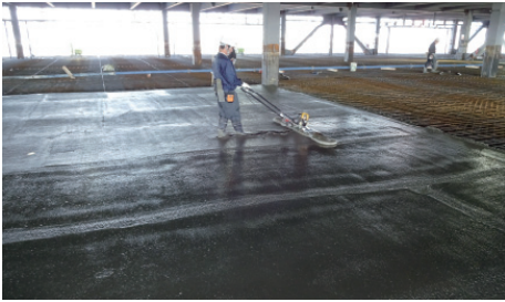
サーファーによる床コンクリート締め固め状況
