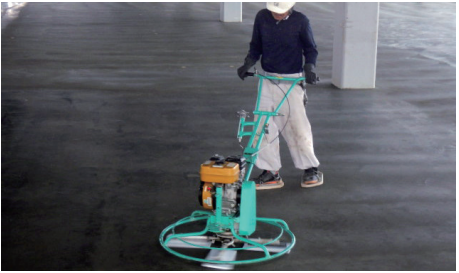
トローウェルによる床コンクリート押え（プラスチック鍔使用）
