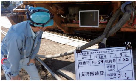
ジオマスターによる支持層の確認
