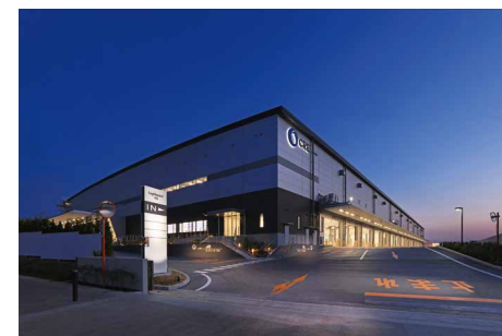
北東側外観夜景
