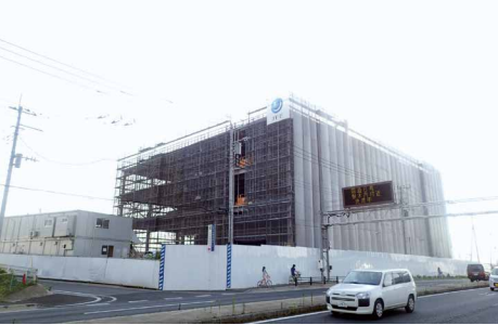
外部足場完了全景
