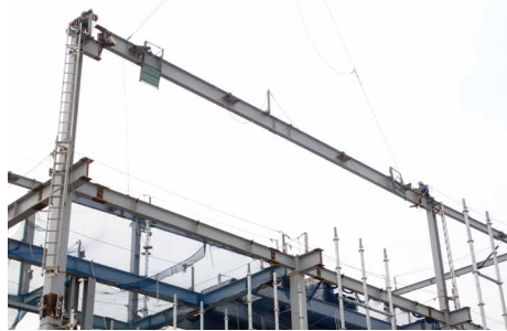
鉄骨建て方状況
