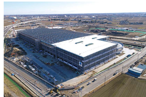
上/施工状況(2017年12月14日時点) 下/施工状況(2018年2月7日時点)
