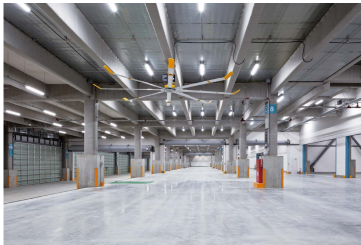
1階倉庫 天井には大型シーリングファン
