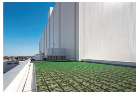
事務所棟屋上緑化
