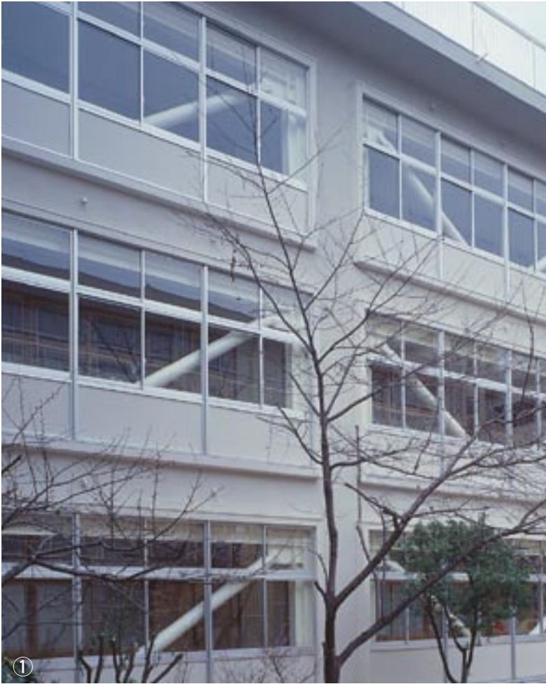
①兵庫県 T小学校 ②兵庫県 T小学校 (内部)
