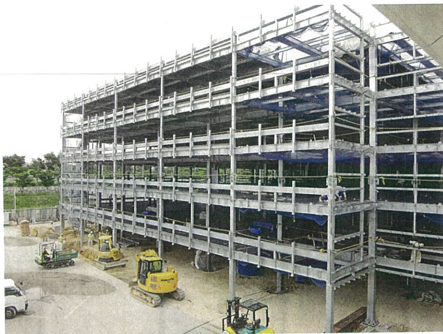
第2期工事の鉄骨建方が行われている那覇空港の新立体駐車場
