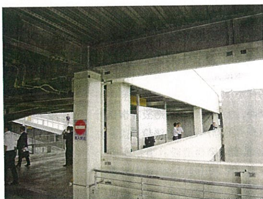
外周部の鉄骨はめっきと塗装で耐久性を高めた
